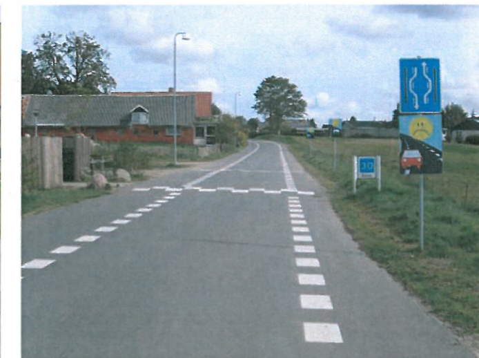
Figur 50: 2-1 vej på en skolevej i Grejs
