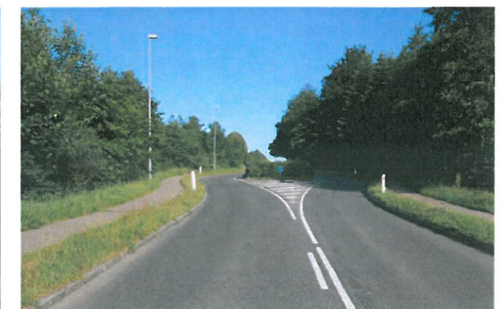
Figur 25: I den vestlige ende af Fillerup er der en markant byportshelle.
