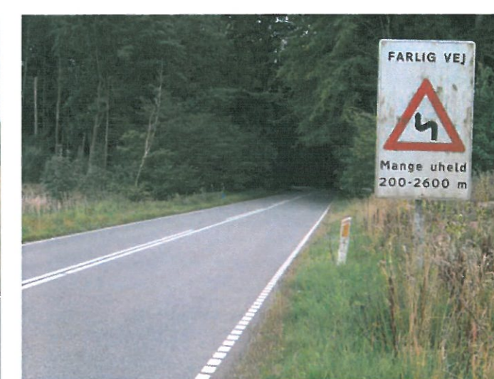
Figur 51: Special skiltning for farlig strækning Grejsdalvej
