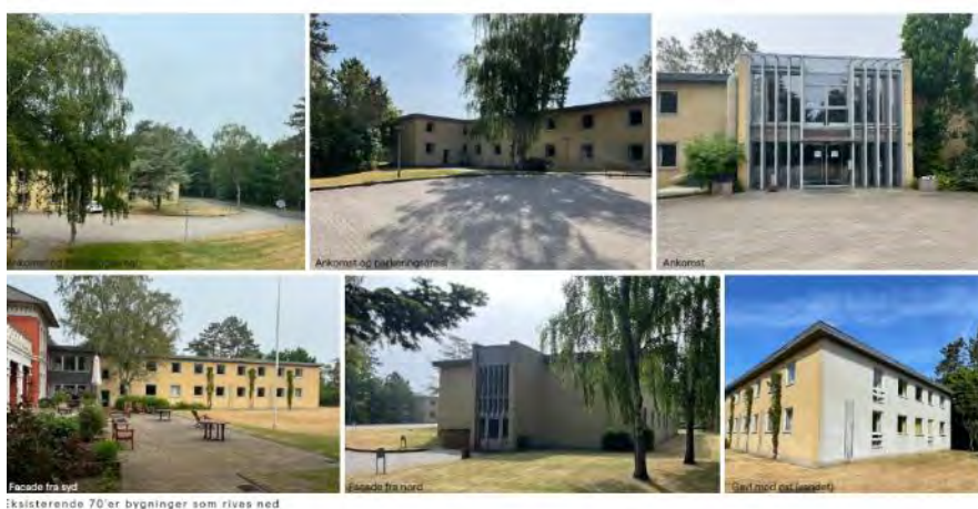
Fotos af de eksisterende bygninger tilføjet i 1960'erne og 1970'erne, der fremstår med flade tage og gule tegl.
